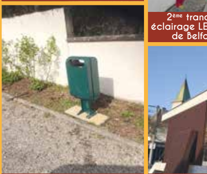
Réfection et mise en place poubelle
