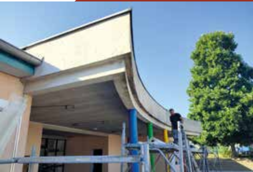
Réfection du préau (5 283 euros)
