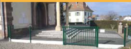
Pose de nouvelles fermetures au cimetière (6 950 euros)
