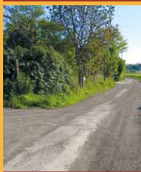
Réfection voiries rue Station et Tuilerie (12 204 euros)
